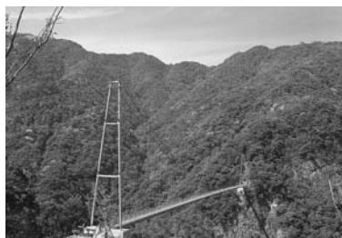
■照葉(てるは)大吊橋 長さ250.0m、高さ142.0mの歩行者専用の鋼製の長経間2ヒンジ補剛吊り橋である。高さ142.0mは歩行者専用の吊り橋としては日本で2番目。
